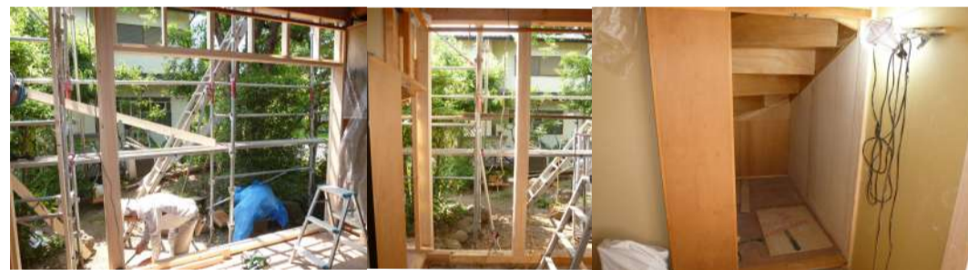
梁、柱の取替えが行われ耐震強度が増し安心
