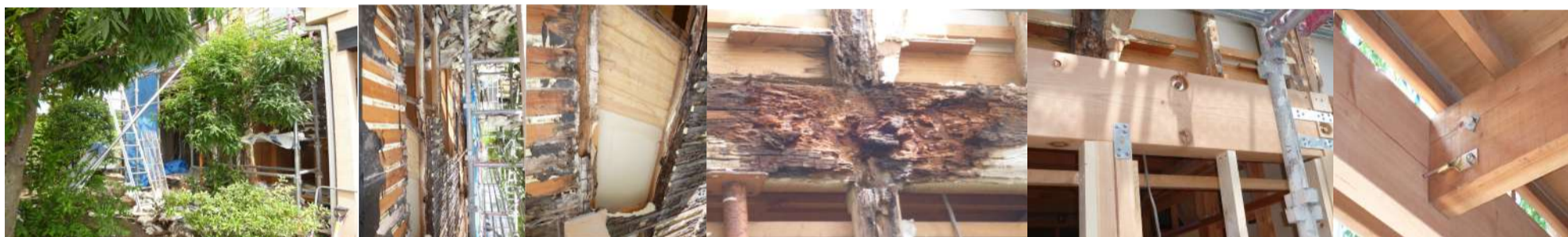
強い地震が来たら倒壊する恐れがある状態・シロアリに食べられた梁を新しく入替ました
